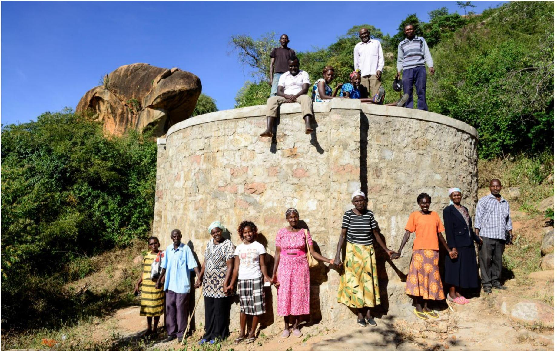
Die Rinne leitet das Regenwasser in einen Behälter aus Beton. Von da aus fließt es in einen großen Tank, der die Wasserstelle speist.
